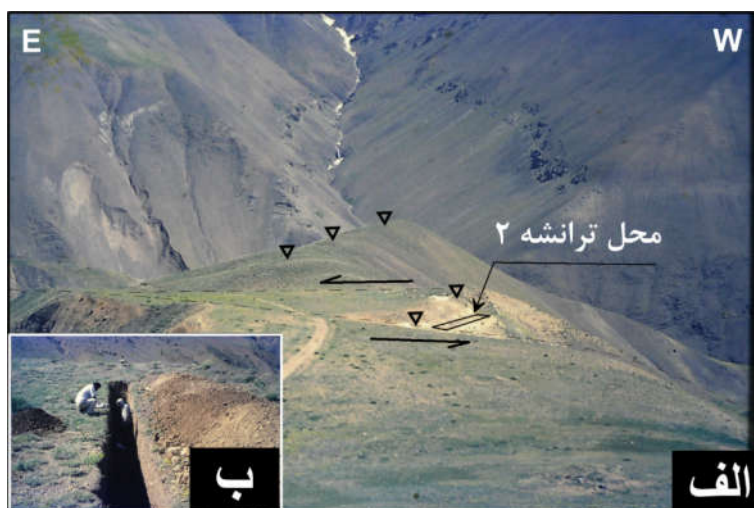
شکل ۵. محل حفر ترانشه شماره ۲. (الف) محل این ترانشه در میانه دو شاخه گسلی قرار دارد که با خطوط ناپیوسته نشان داده شده است. سه گوش‌های سیاه‌رنگ، جابه‌جایی پشته‌ها را به صورت چپ‌بر نشان می‌دهند. (ب) تصویری از ترانشه حفر شده (نگاه به سوی جنوب).
