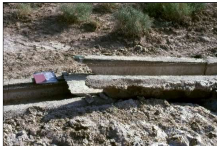
شکل ۴. مثال‌هایی از بیشینه اثرات ناشی از زمین‌لرزه ۲۵ شهریور ۱۳۵۷؛ الف) شکستگی و روانگرایی در غرب چاه صادق (بربریان، ۱۹۷۹a)؛ ب) شکستگی کانال آب بصورت رورانده در فهالنج در حدود ۲۰ کیلومتری جنوب طبس (بربریان، ۱۹۷۹b).
