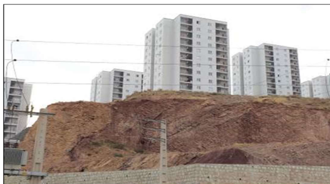
شکل ۶. احداث برج‌های فاز ۱۱ روی واحدهای سنگی گسلیده (دید به سمت شمال غرب).
